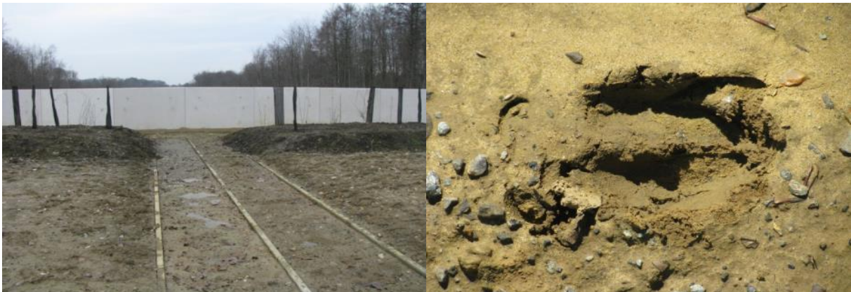
Figuur 10 Op het ecoduct werd een zand- en een leembed aangelegd om de monitoring via sporen mogelijk te maken. Zand- en leem reageren verschillend in functie van het weer: bij hevige regen worden sporen in leem moeilijk leesbaar, in nat zand daarentegen wel. Bij droog weer is de werking omgekeerd. Het bed wordt gladgestreken aan het begin van de monitoringperiode en bij de controle worden de sporen gefotografeerd en gedetermineerd.
